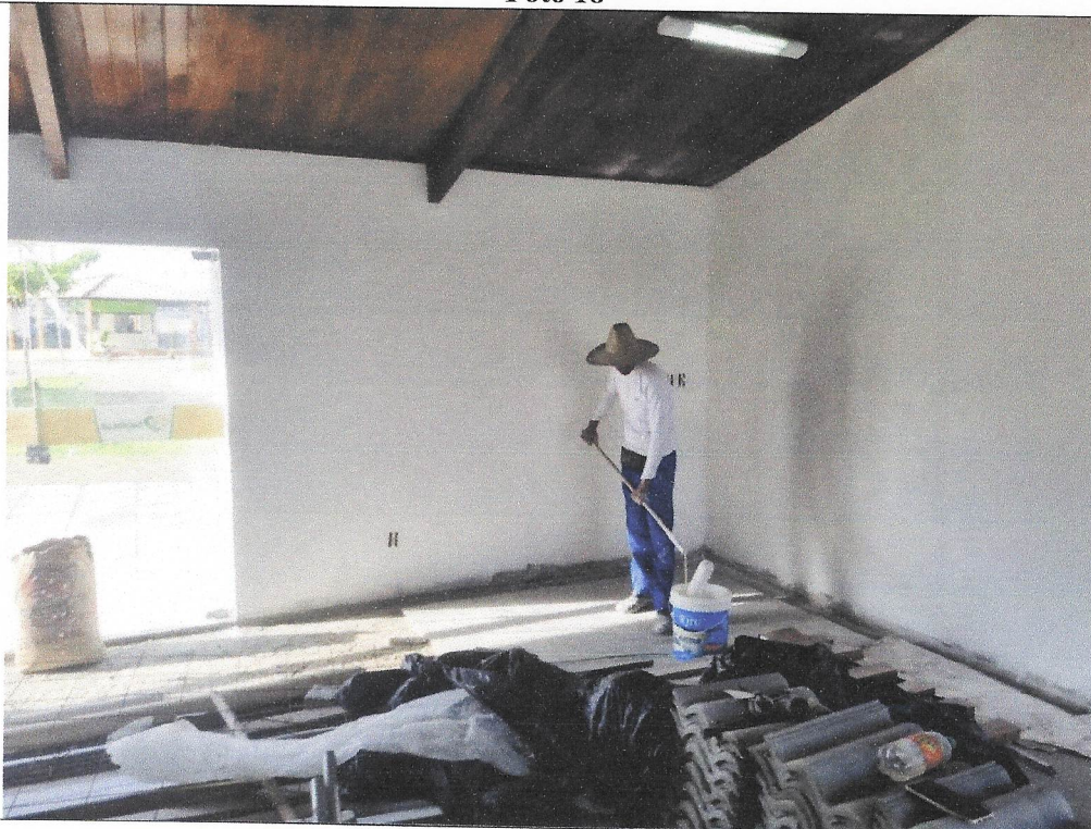
Preparo para Pintura- Centro da Melhor Idade
