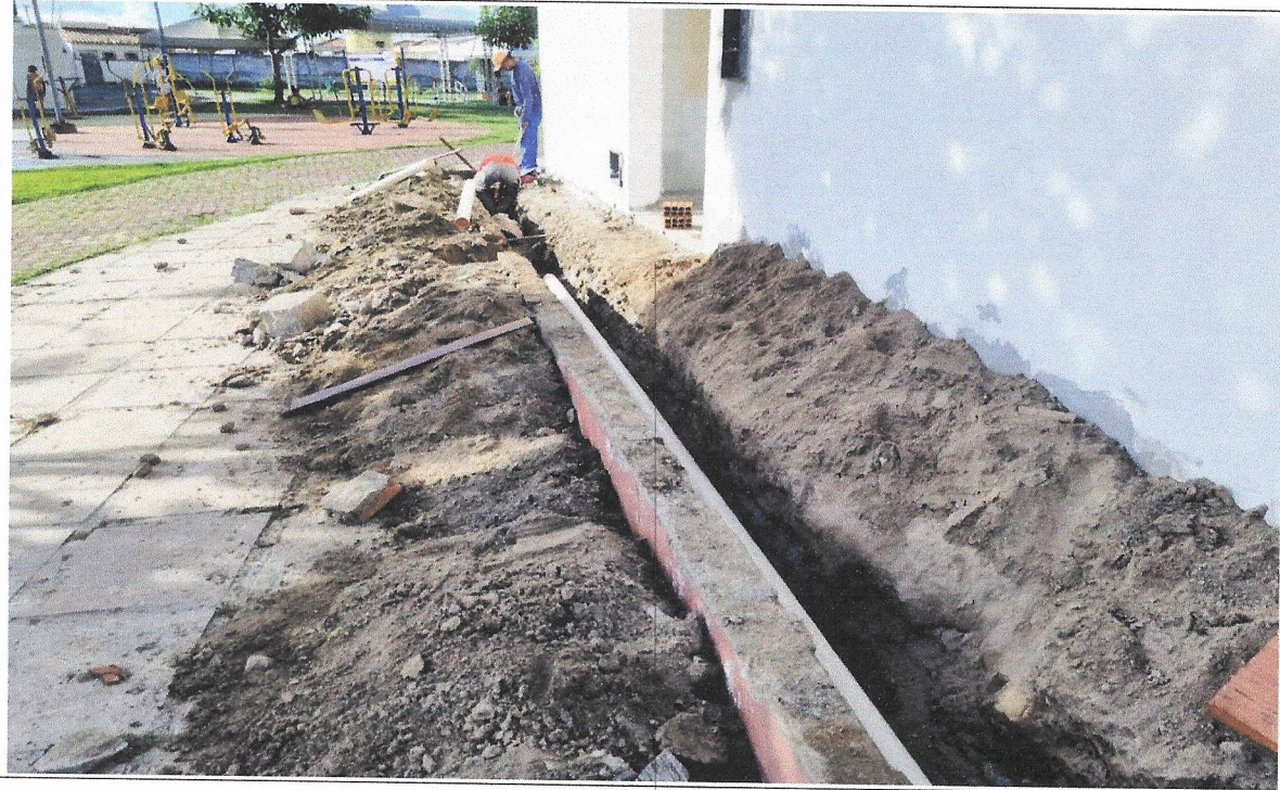
Execução de Caixa de Passagem Hidráulica- Centro da Melhor Idade
