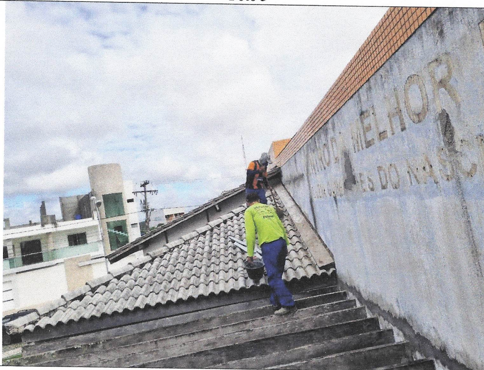
Revisão de Telhado- Centro da Melhor Idade
