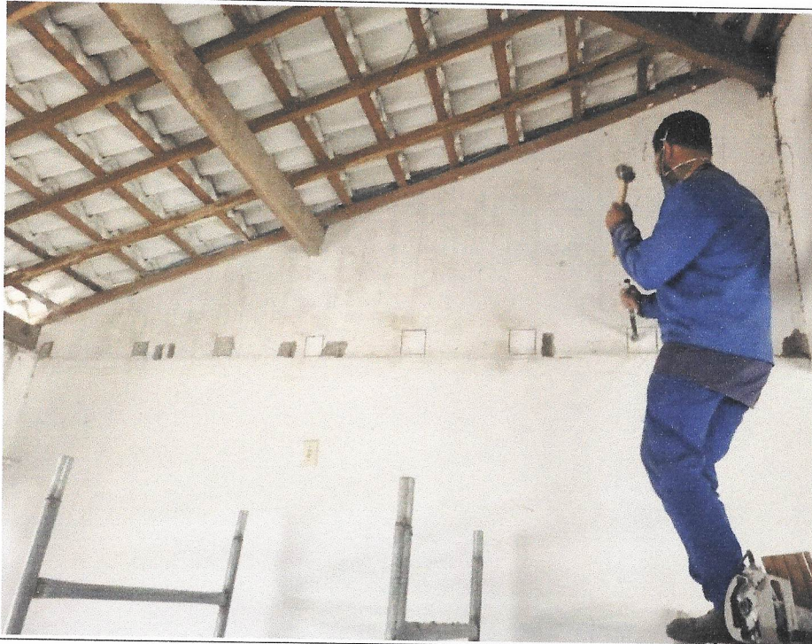
Instalação de Forro PVC- Centro da Melhor Idade
