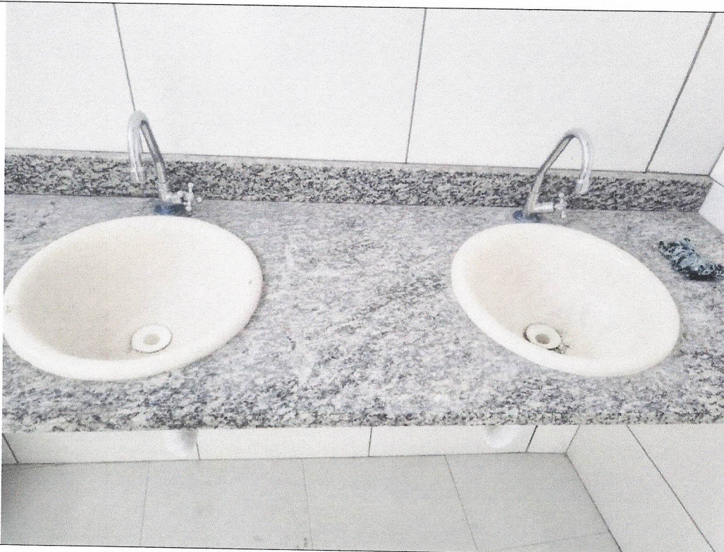
Instalação de Torneiras Cromadas - Centro da Melhor Idade
