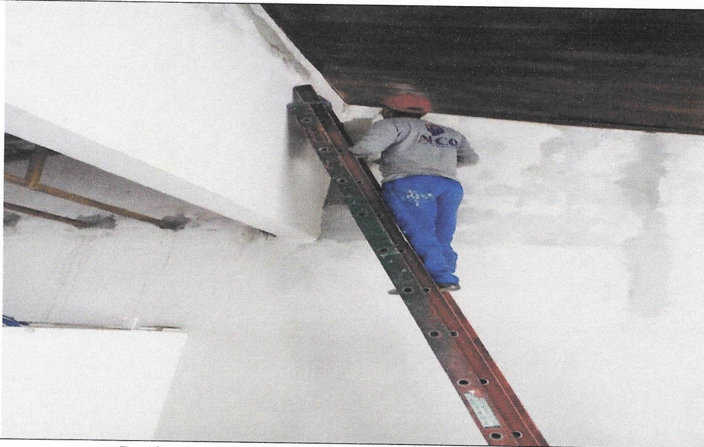
Revisão de Forro de Madeira- Centro da Melhor Idade
