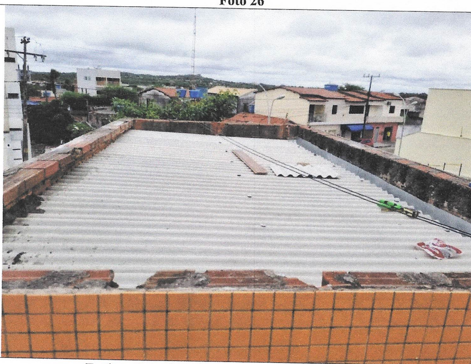
Fechamento de Telhado- Centro da Melhor Idade
