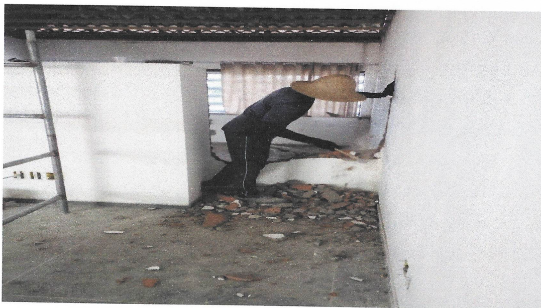
Demolição de Alvenaria- Centro da Melhor Idade
