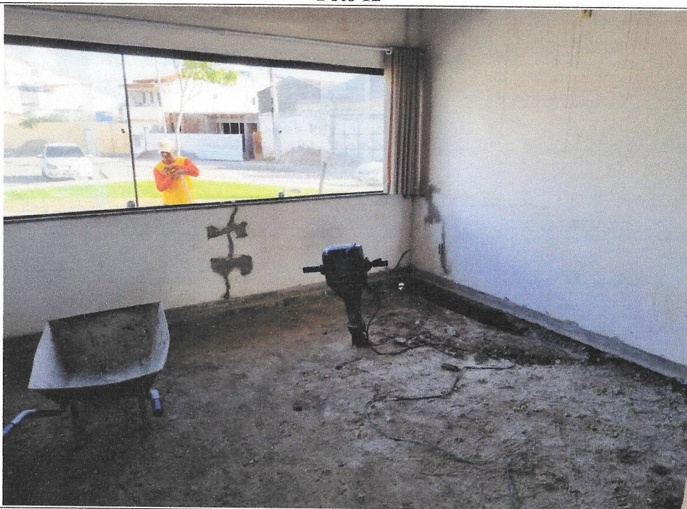
Demolição de Piso de Alta Resistência- Centro da Melhor Idade
