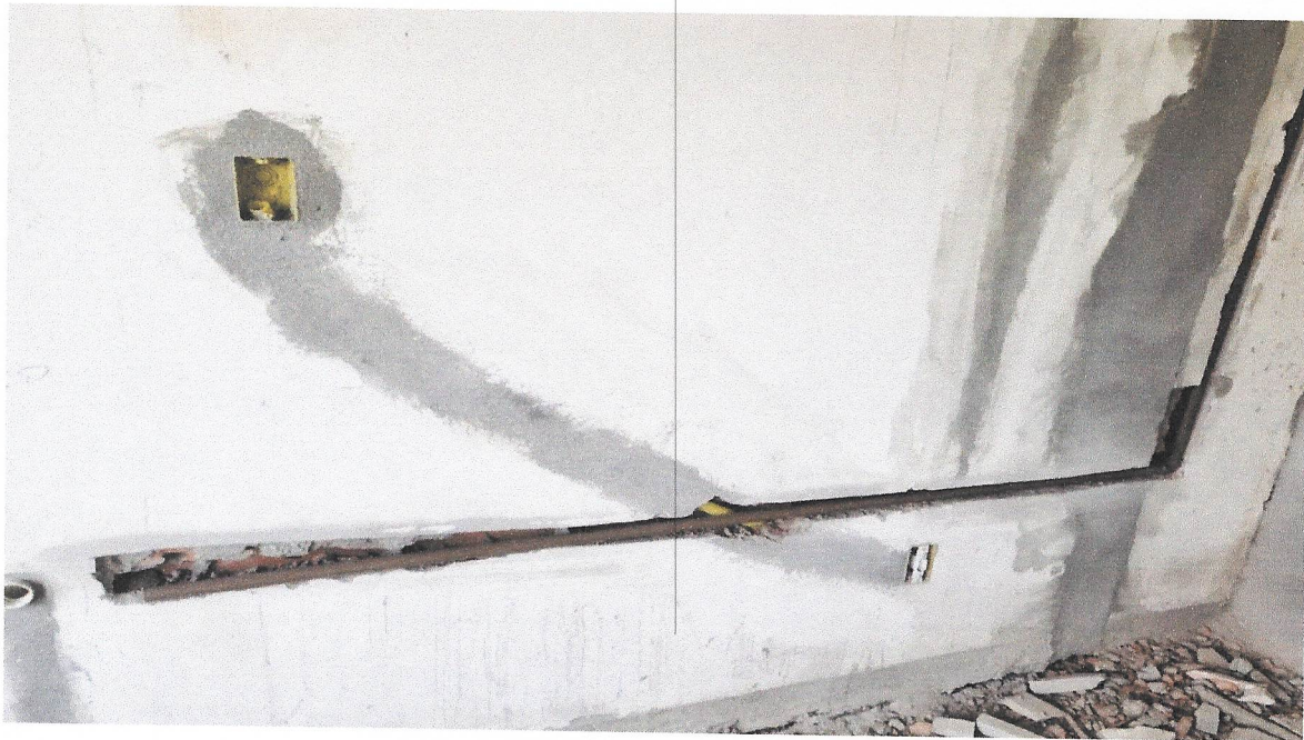
Execução de Caixa de Passagem Elétrica- Centro da Melhor Idade
