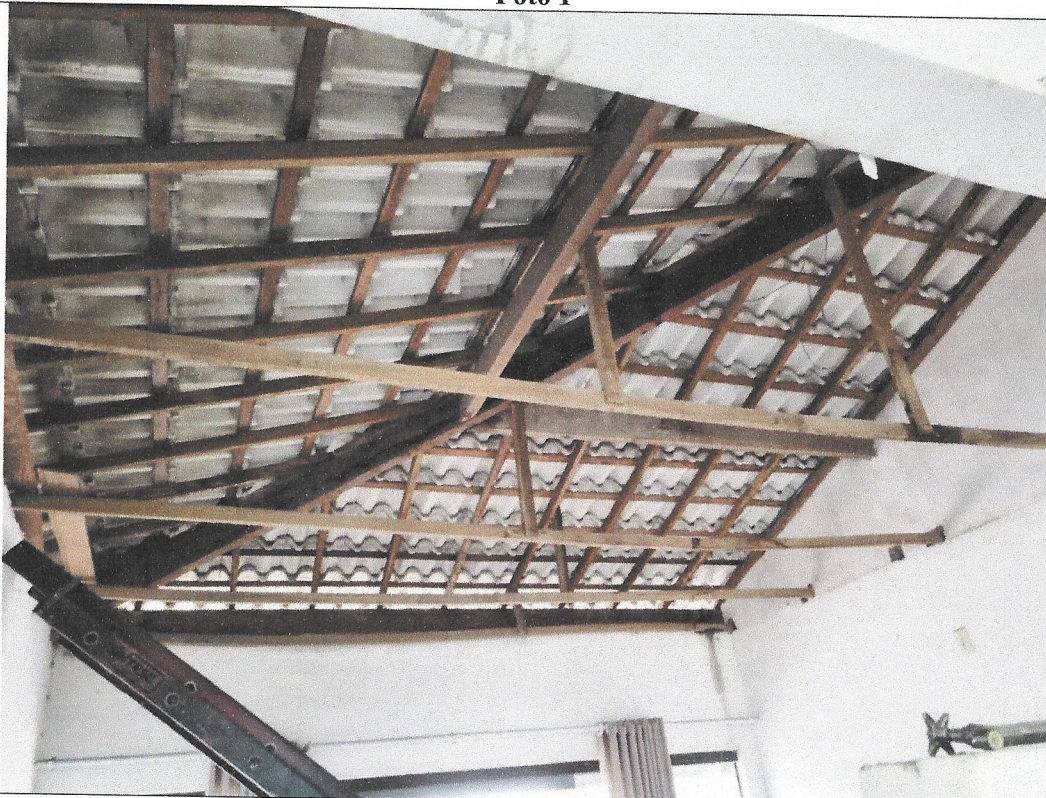
Remoção de Forro PVC- Centro da Melhor Idade
