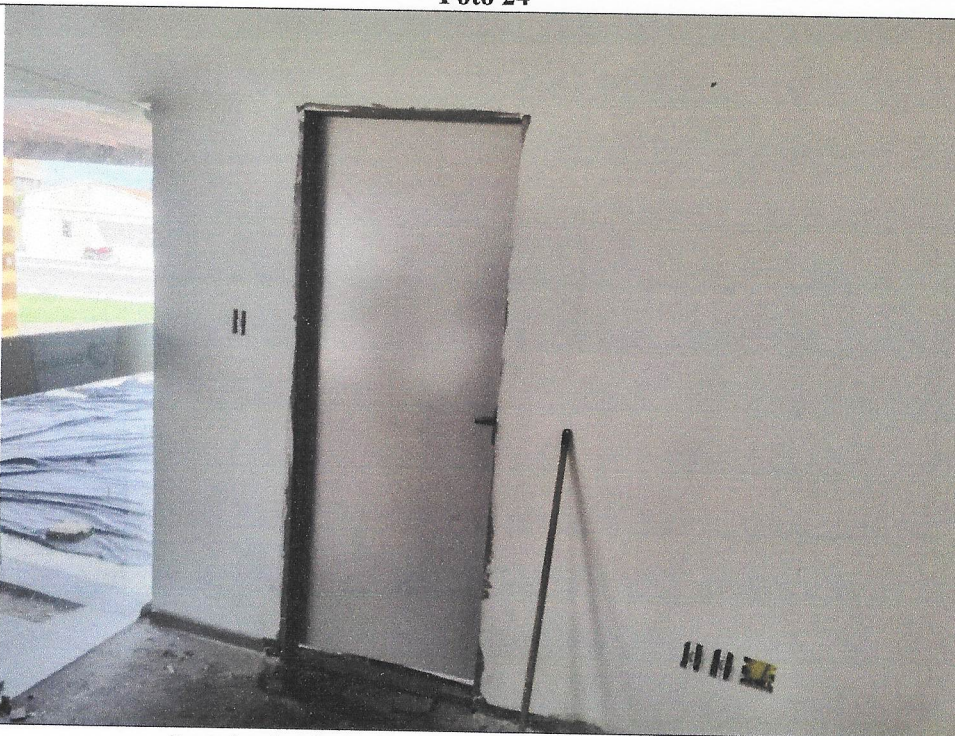
Instalação de Esquadria- Centro da Melhor Idade
