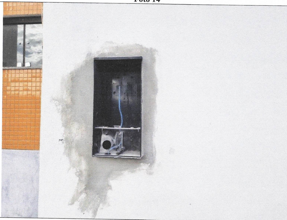
Instalação de Quadro Elétrico- Centro da Melhor Idade
