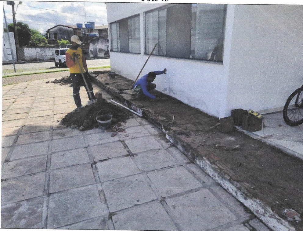
Execução de Passeio- Centro da Melhor Idade
